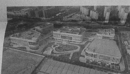
中车张家港氢能基地项目竣工
